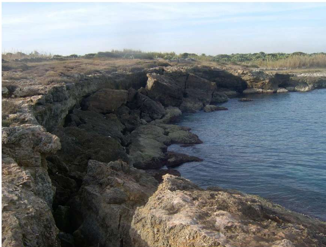
Crolli nella falesia interessata alla base da un profondo solco di battente (Foto Di Leva)
