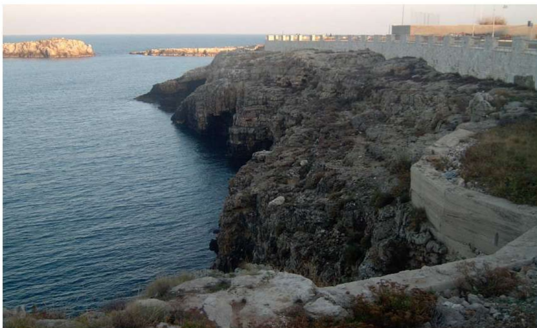
Esempio di costa "convessa" in corrispondenza del lungomare (Foto Di Leva)
